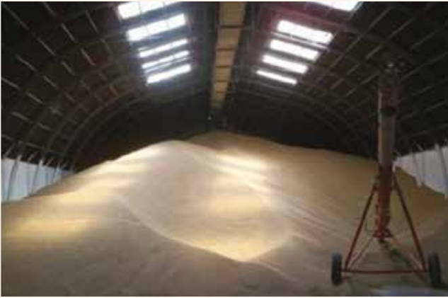
Şekil 3. Yığın hâlinde depolama.
